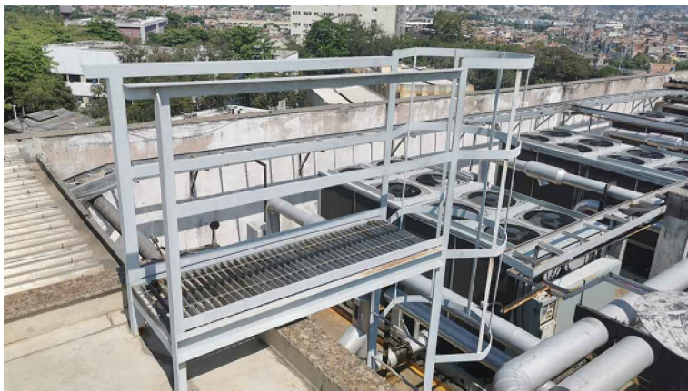
FOTO 4: PASSARELA 2 (SIMILAR A 3) A SER REPINTADA (COR BRANCA) LAC (m): 0.70 X 0.90 X 1.50 ESCADA H = 4.45 m
