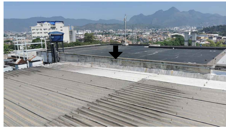
FOTO 9: ELETRODUTO A SER REMOVIDO E REINSTALADO AO FUNDO: CAIXA D'ÁGUA EXISTENTE E PASSARELA 3
