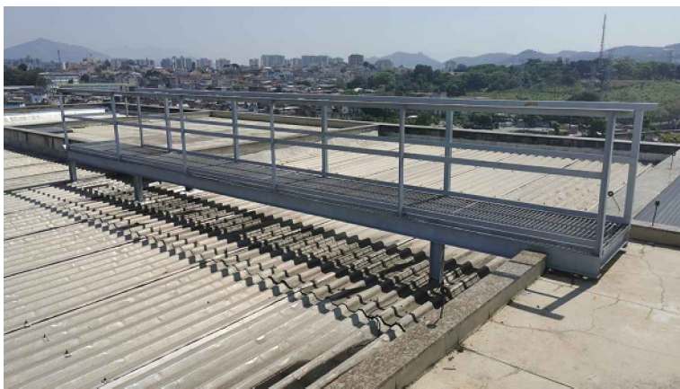
FOTO 3: PASSARELA 1 A SER REPINTADA (COR BRANCA) LAC (m): 0.70 X 0.90 X 7.50
