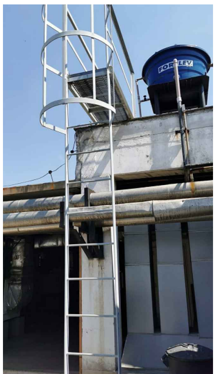
FOTO 5: PASSARELA 3 (SIMILAR A 2) A SER REPINTADA (COR BRANCA) ESCADA H = 4.45 m
