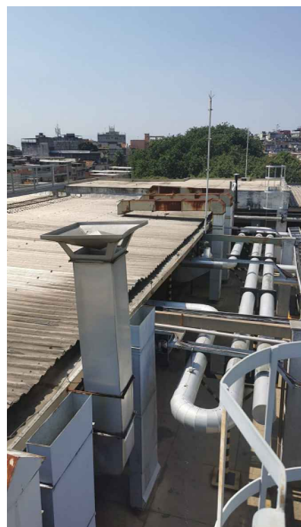
FOTO 6: SUPTES METÁLICOS A SEREM RECUPERADOS E REPINTADOS (COR BRANCA)
